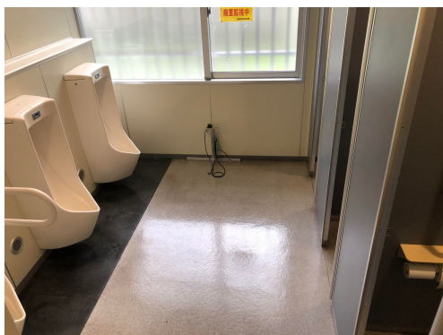
Fig. 13: 総合研究棟 B 1F のトイレ
